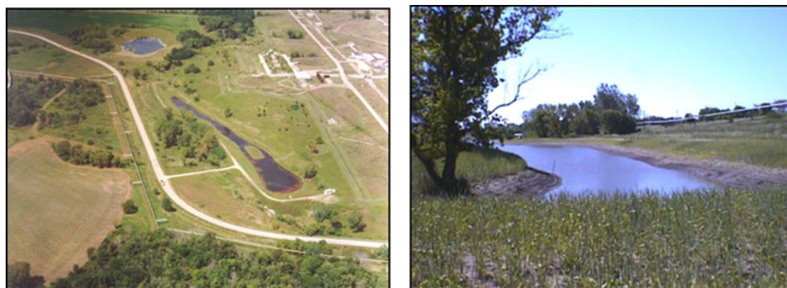
图 12.4 湿地鸟瞰图(左)和位于爱荷华州中部镇的爱荷华陆军弹药厂的自由水面池塘的入口水平流照片。湿地中种植了慈姑 (本地植被)，并对 RDX 污染物进行处理，以满足污水排放标准。
