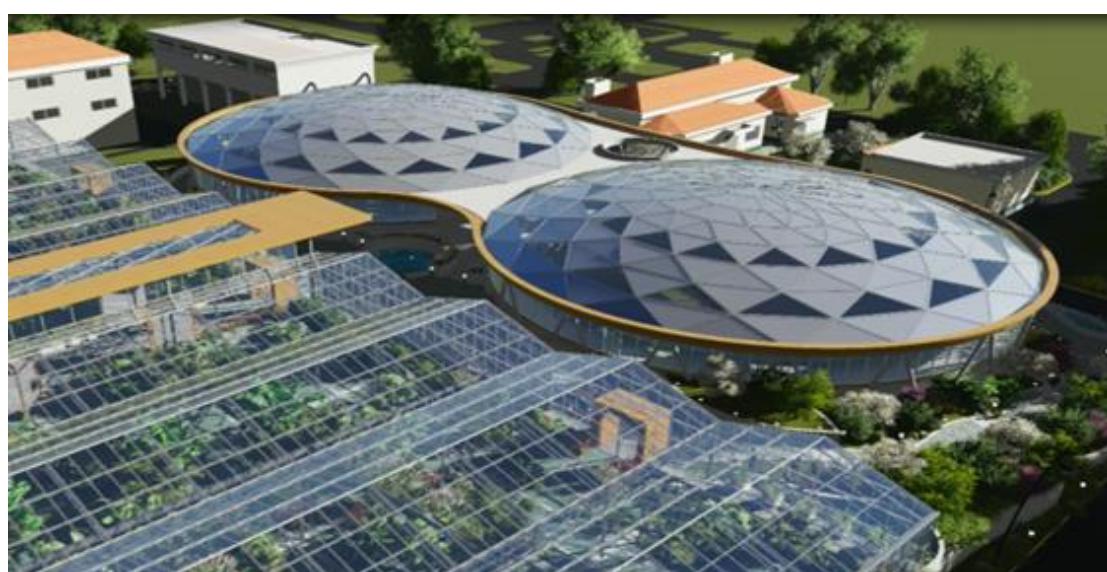
图 17.4 吴淞 WWTF，图片由 Organica Water 提供
