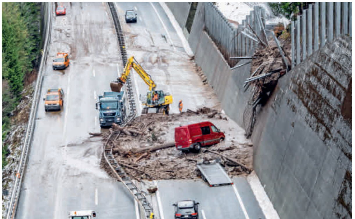
Abb 1 Eine Hangmure von rund 400 m 3 verschüttete am 23. Januar 2018 die Gotthardautobahn A2 zwischen der Wilerplanggen und der Ripplistal-Galerie über eine Breite von 50 m.
