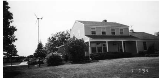
Bergey 10 kW, Vermont
