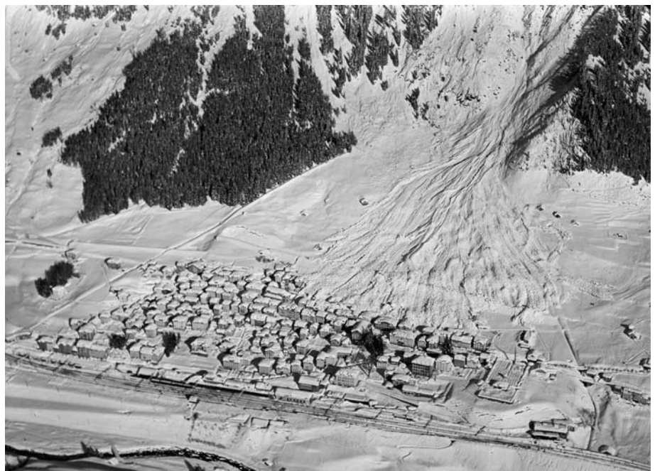
Abbildung 7: Ablagerungskegel der Vallascia-Lawine vom 12. Februar 1951 auf den östlichen Dorfteil von Airolo. Gut sichtbar ist der überflossene Auffangdamm oberhalb des Dorfes und die verschüttete, oberste Häuserreihe östlich der Kirche (Foto: Militärflugdienst/Archiv SLF).
