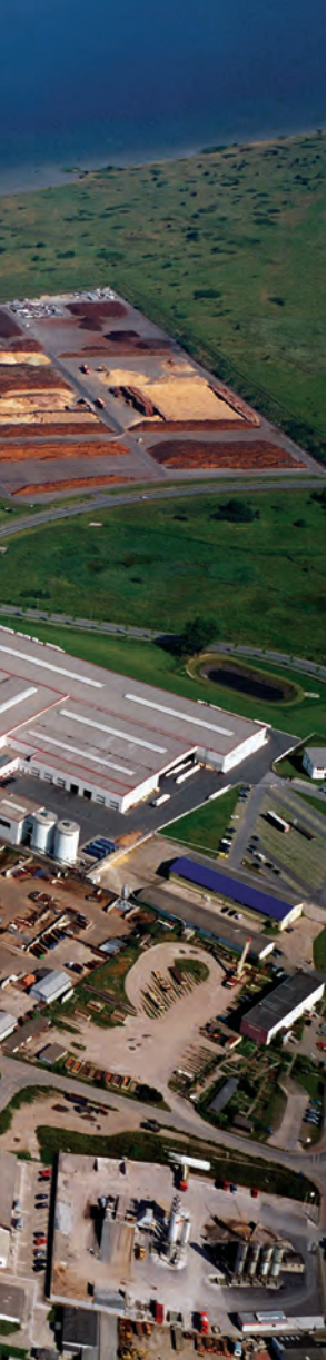
Fig 2 Timber Cluster Wismar (Mecklenburg- Vorpommern). Photo: Klausner Holz
