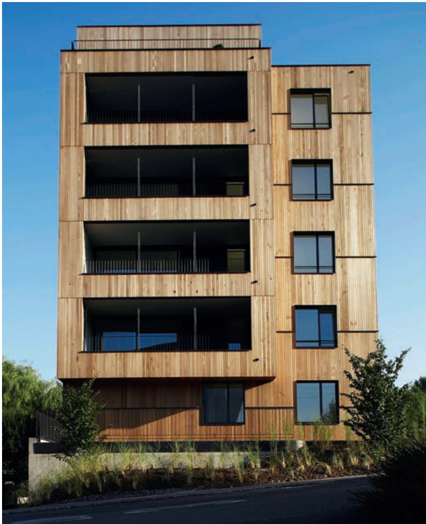
Abb 2 Erstes sechsgeschossiges Haus der Schweiz in Holzbauweise (Steinhausen ZG).
