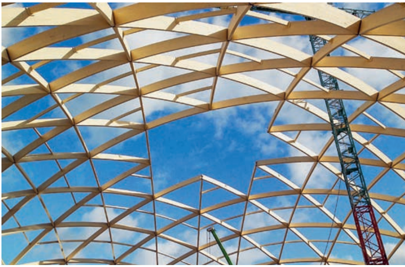
Abb 2 Wie der Saldome in Riburg sind viele moderne Holzbauten aus Leimholz gefertigt. Foto: Häring, Eiken/Lignum
