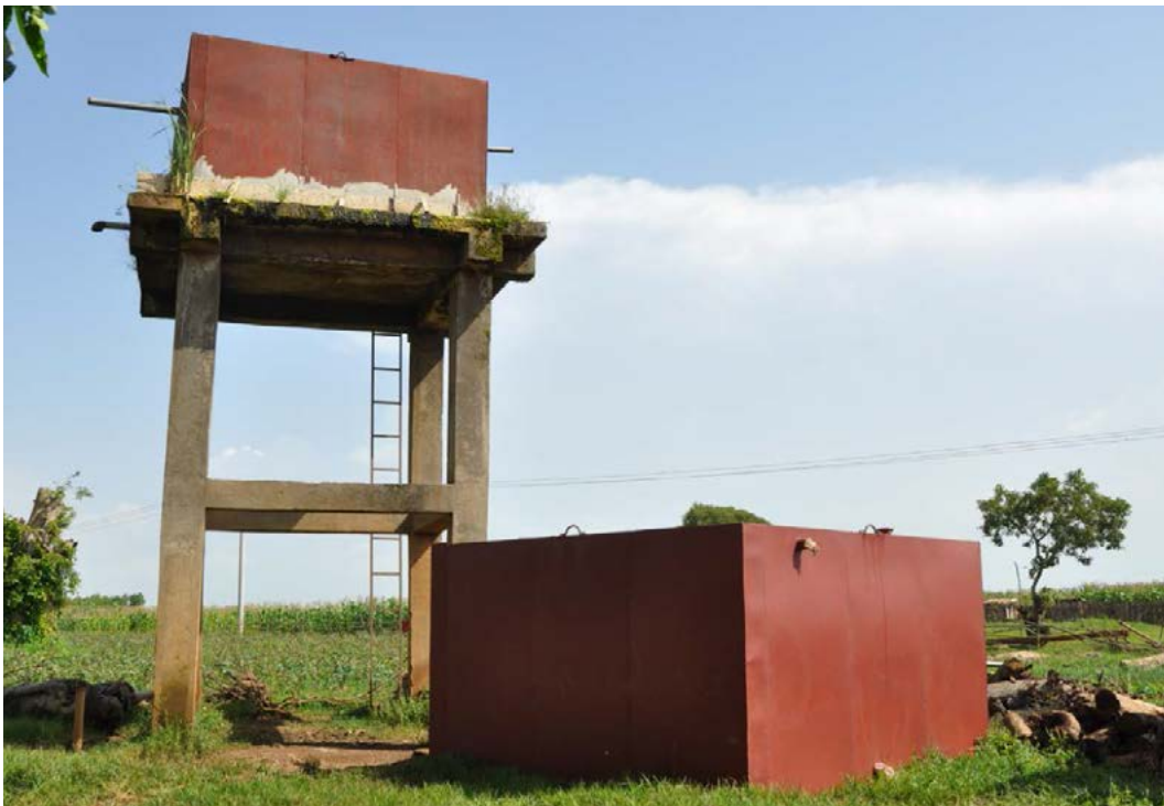
Figure A5.5. Cette citerne d'eau coulait et se rouillait depuis de nombreuses années à Lalibela kebele, dans l'état régional d'Amhara. Celle qui se trouve au sol est une nouvelle citerne qui remplacera l'ancienne
