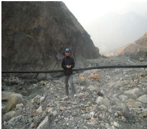
L'augmentation des sédiments signifie que la hauteur relative du passage de la canalisation est plus faible
