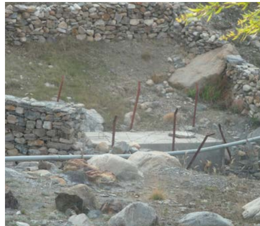
Prises d'eau des rivières susceptibles d'être endommagées par les glissements de terrain et les inondations
